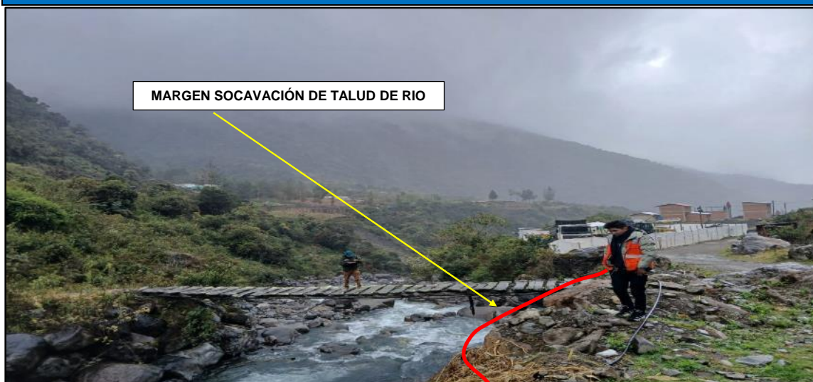
FIGURA N°01: SE APRECIA LA SOCAVACIÓN DE TALUD DE CAMINO MARGEN DERECHA DEL RIO ARAZA
